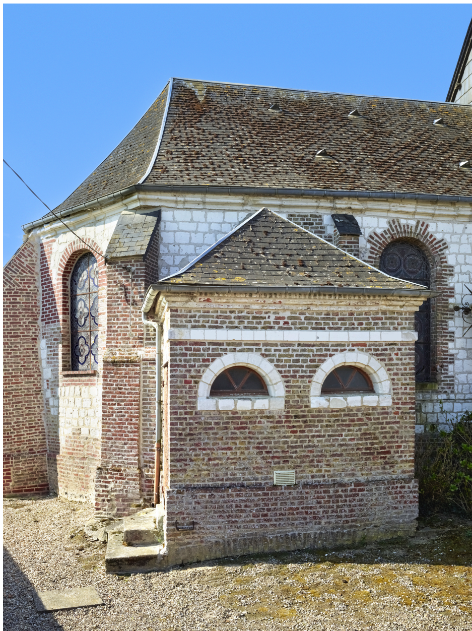
Vue de l'ancienne chapelle, depuis le nord.
