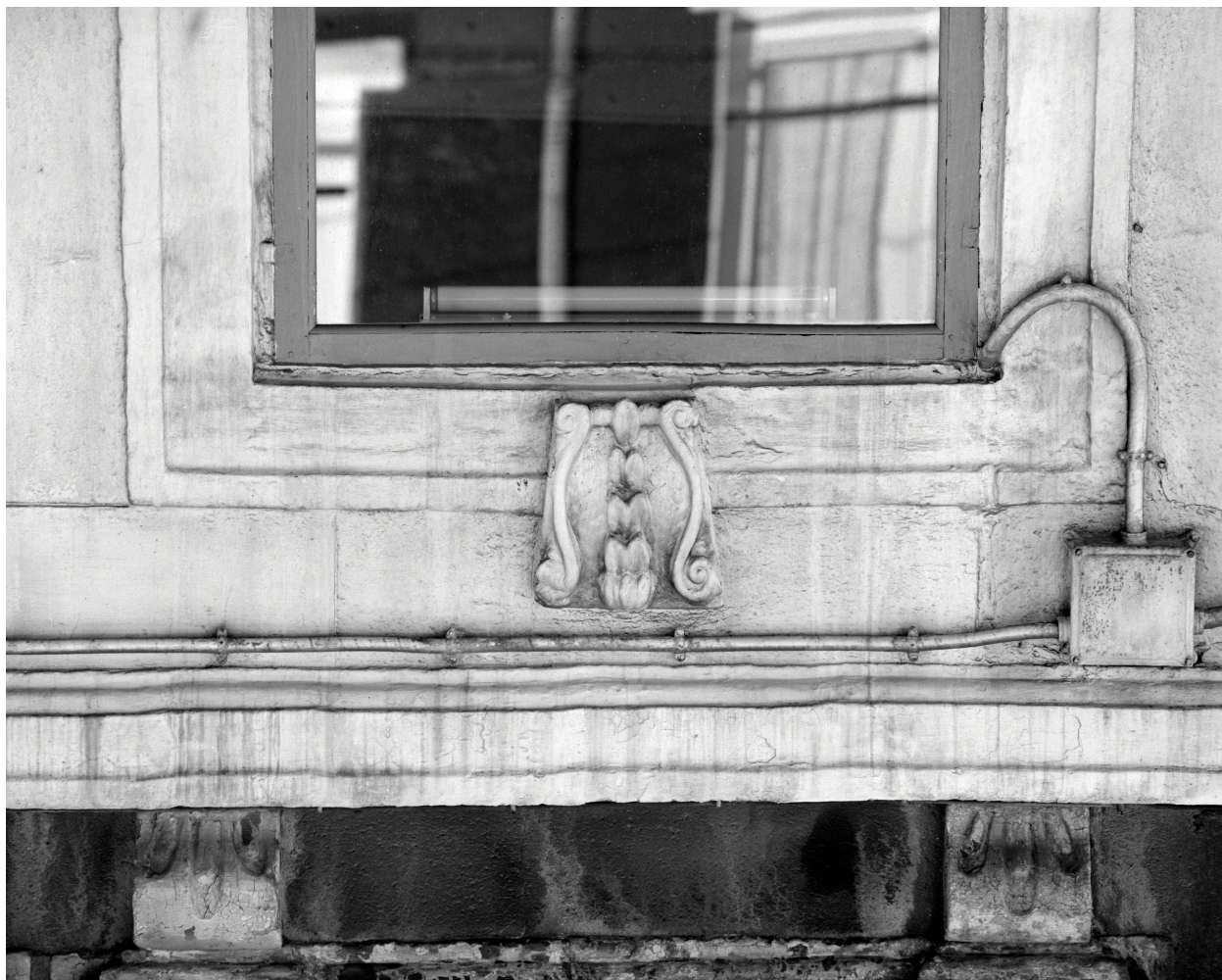
Linteau, rez-de-chaussée, clé n° 4.
