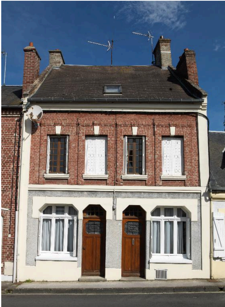
Maison à deux unités d'habitation, rue aux Poulets.
