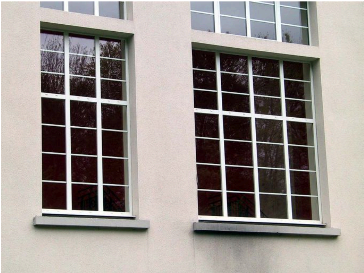
Façade arrière, avant-corps central, 1er étage, détail : baies.
