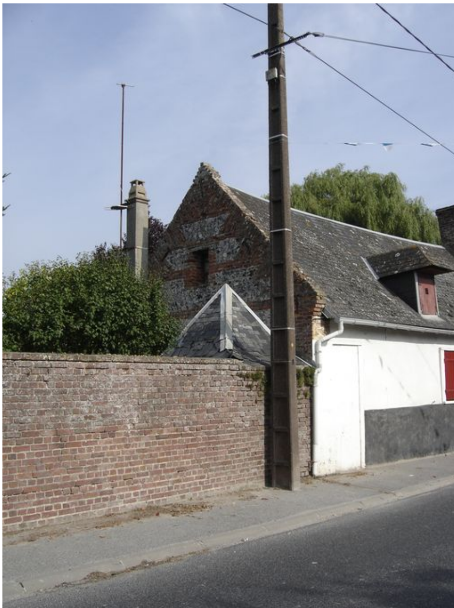
Détail d'un des deux pignons.
