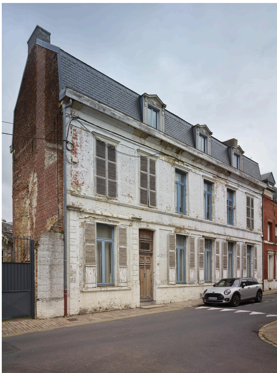
Maison, 22 rue Baillon : toiture brisée caractéristique des constructions du XVIIIe siècle.
