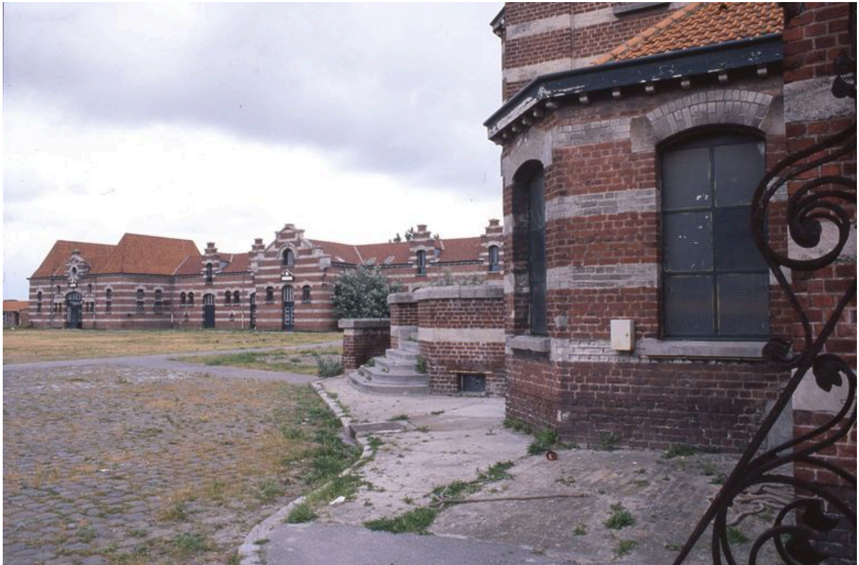
Vue d'ensemble sur cour des étables, vue générale depuis l'habitation du chef d'élevage en 1990.
