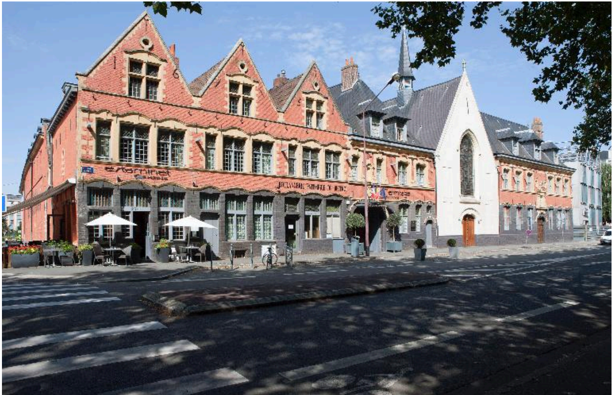
Façade principale donnant sur la rue de Paris, vue générale prise de trois-quarts gauche.
