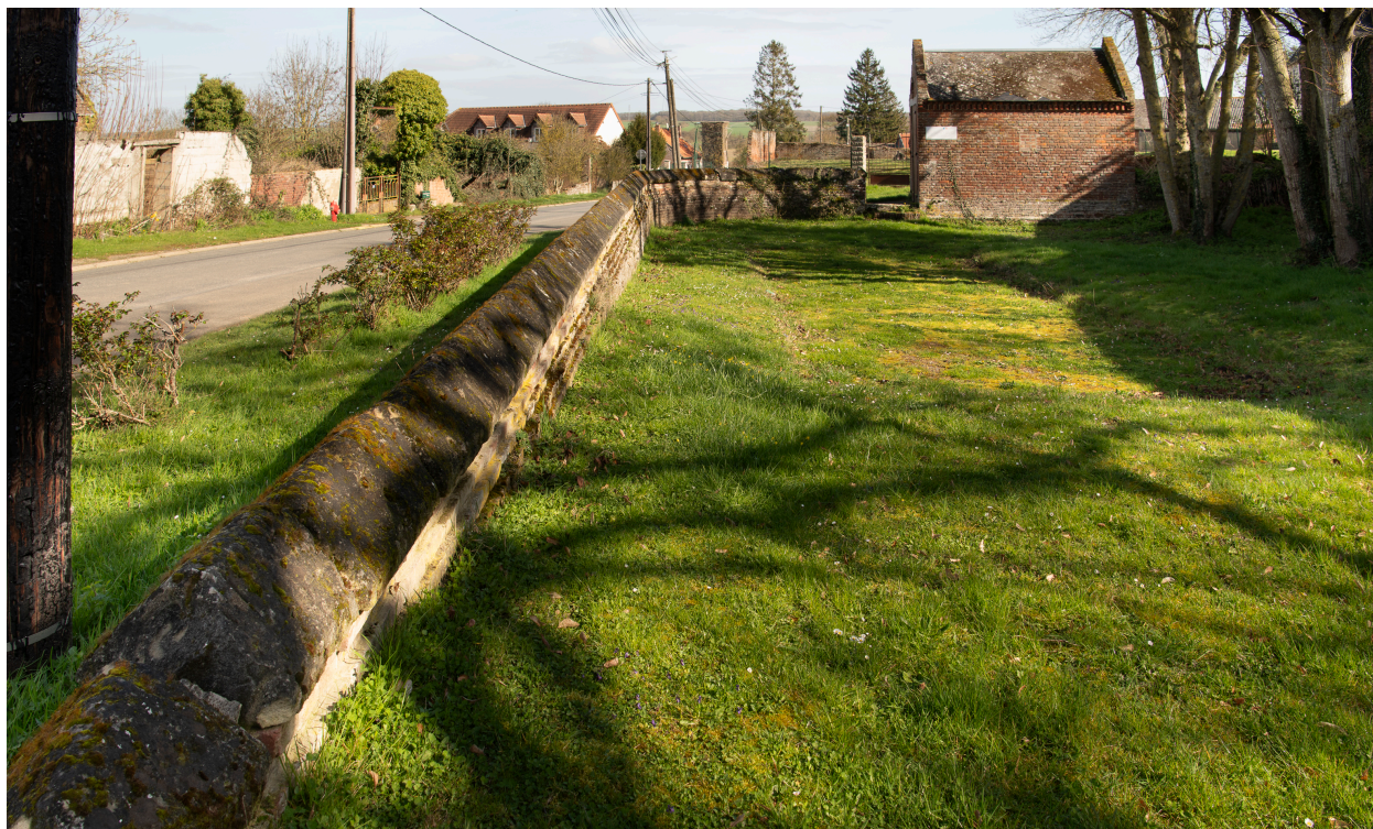
Ancienne mare, Grande Rue.
