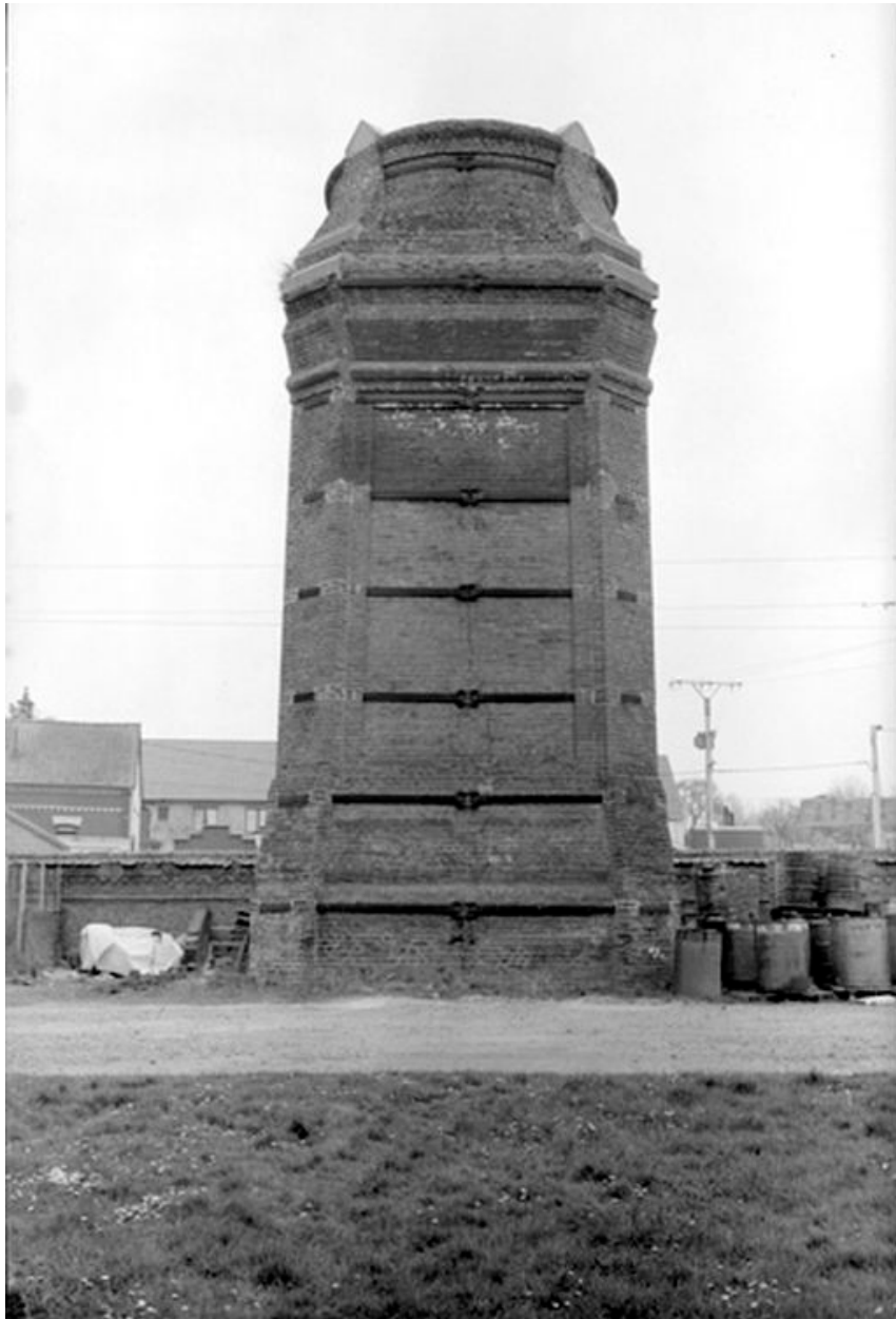
Vue de la cheminée d'usine.
