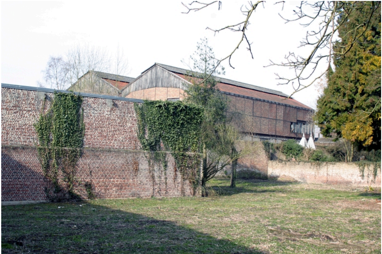
Les entrepôts vus depuis l'est.
