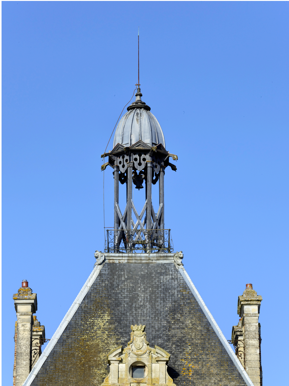
Détail du clocheton, depuis le sud.
