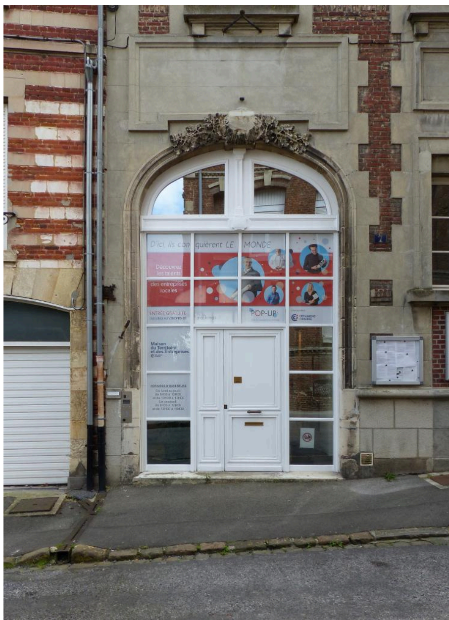
Vue de l'ancienne porte cochère.
