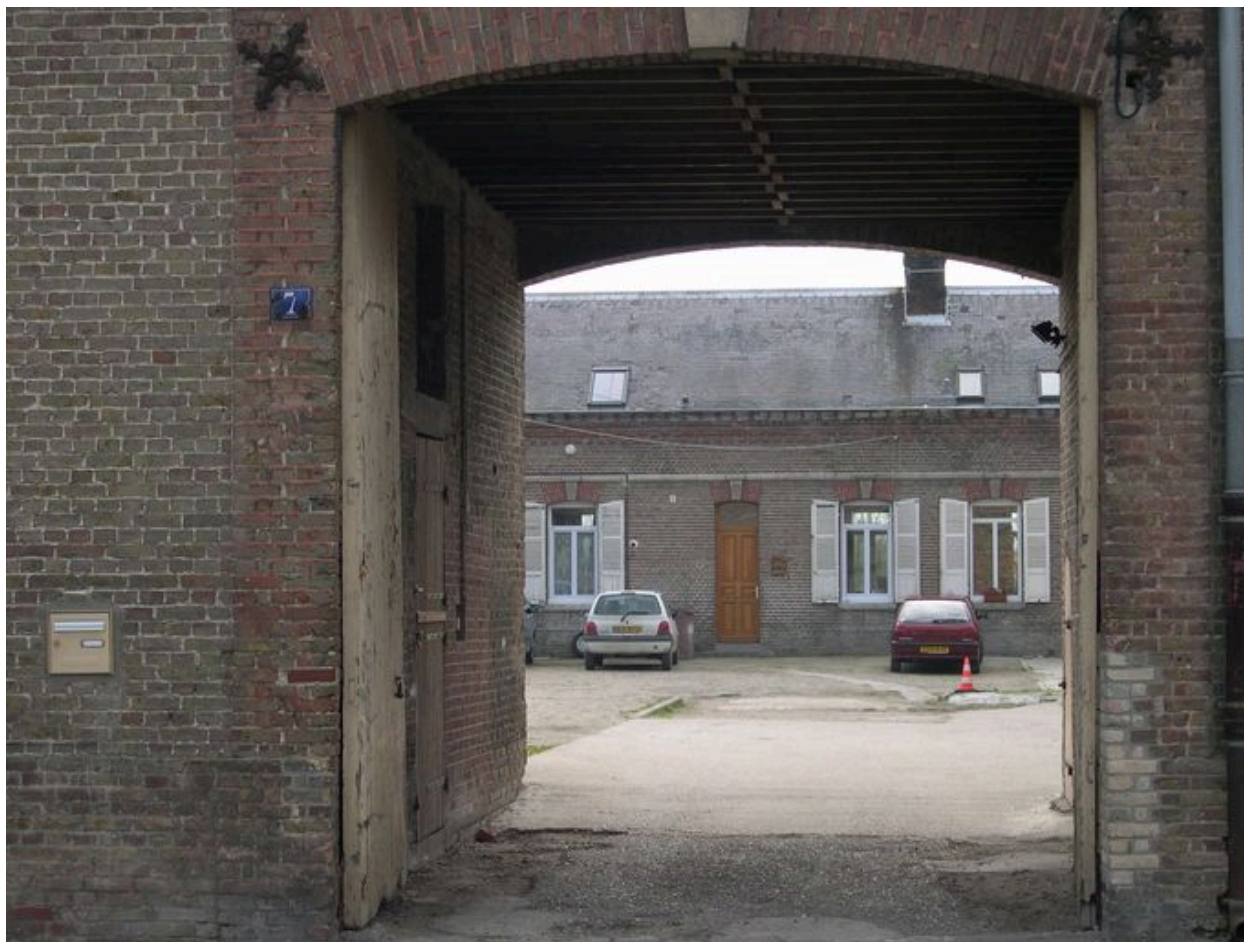
Vue du corps de logis.
