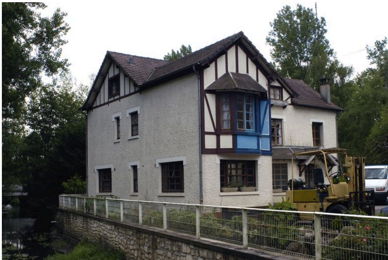
Vue d'ensemble sur cour du logement patronal.
