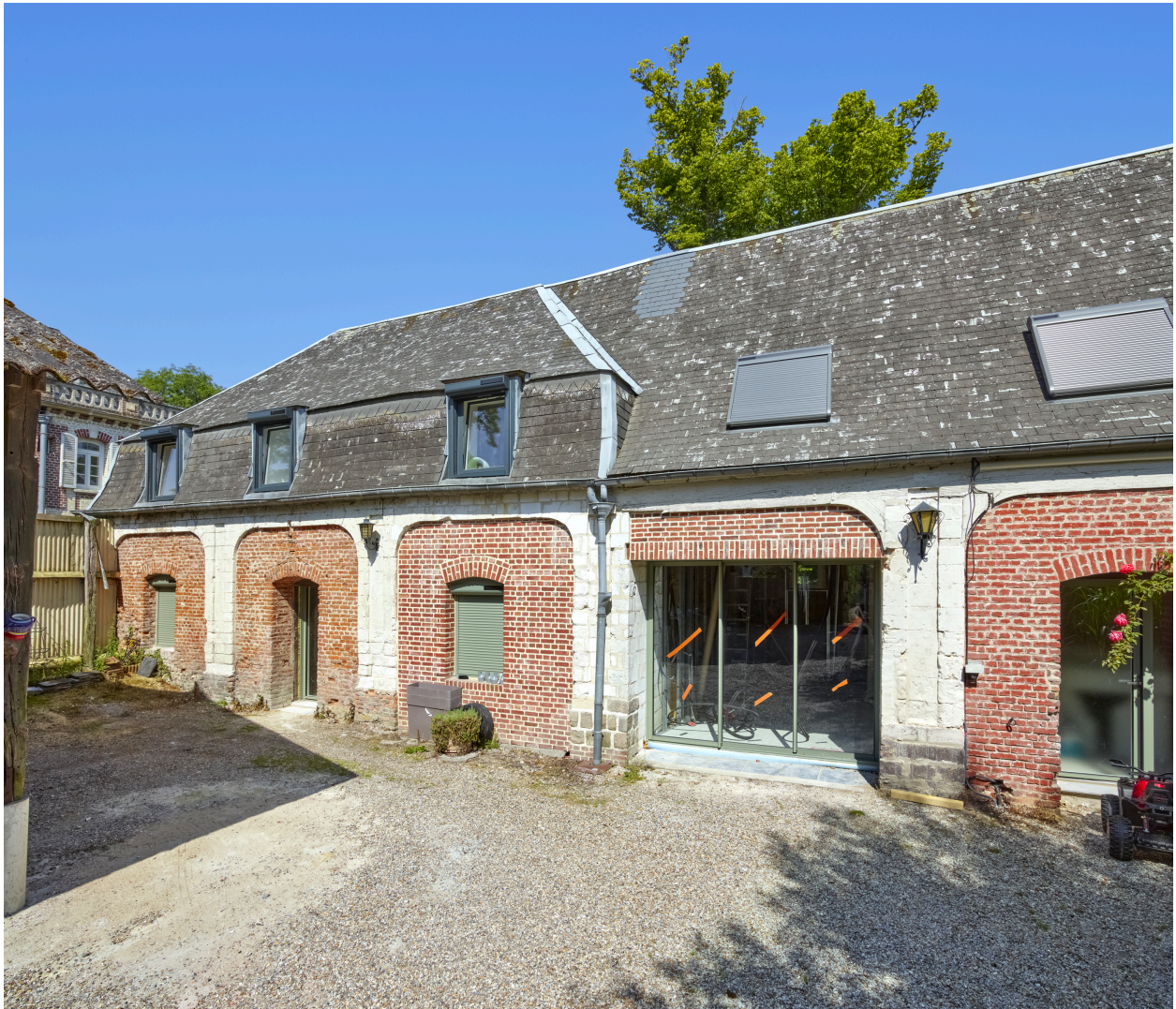
Vue sud du bâtiment nord, depuis la cour.
