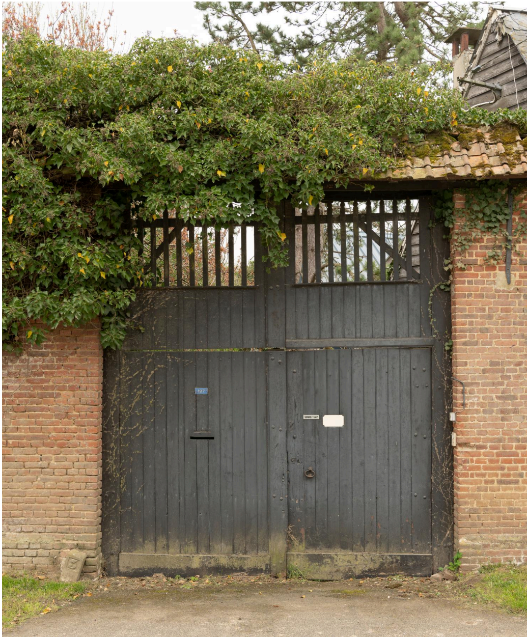
Entrée charretière, n°197 de la rue de Couvremont, vue prise depuis le nord.
