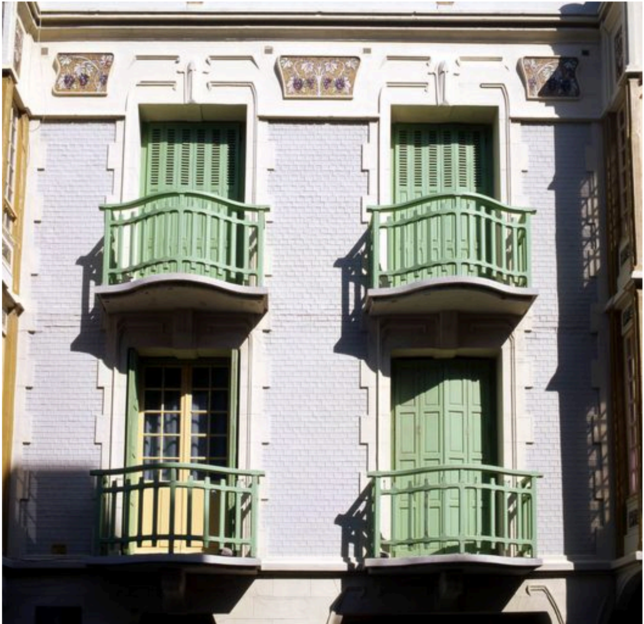
Détail des travées situées entre les oriels.
