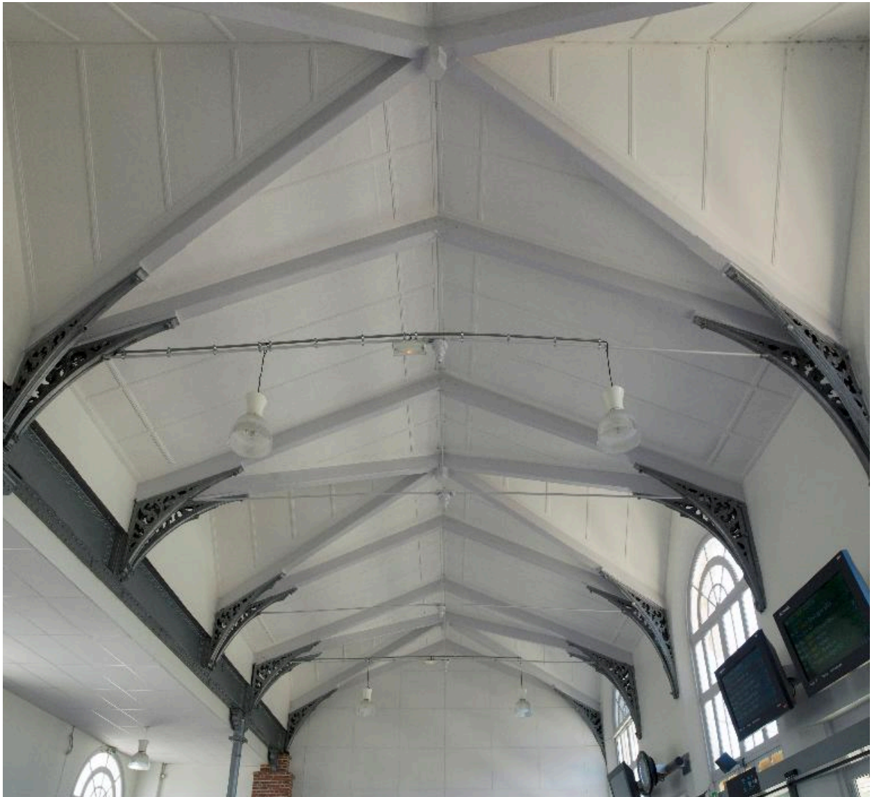
Vue de la charpente en bois et fonte à l'intérieur de la gare.
