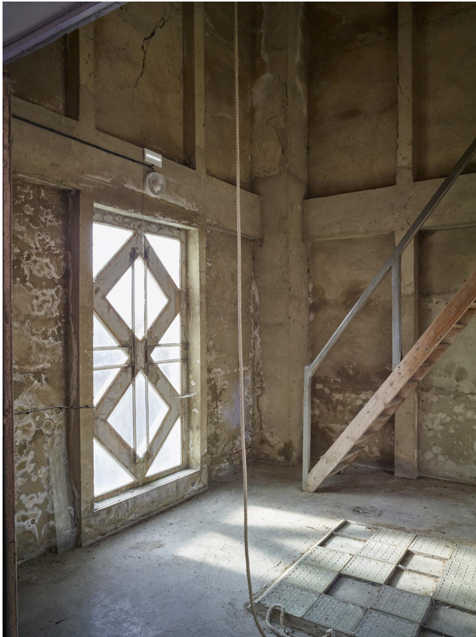
Verrière et escalier de la tour-clocher.
