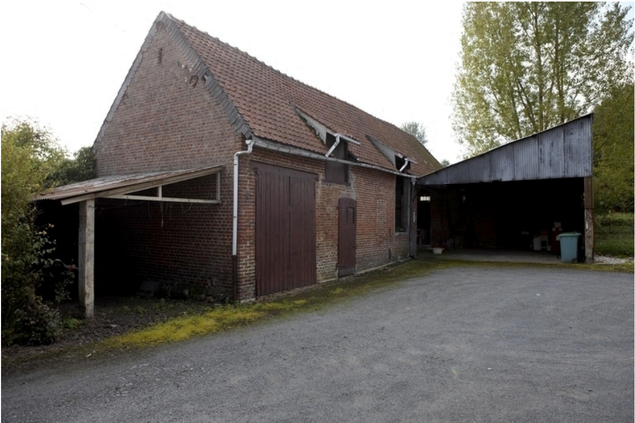
Vue du bâtiment servant à stocker les fruits.
