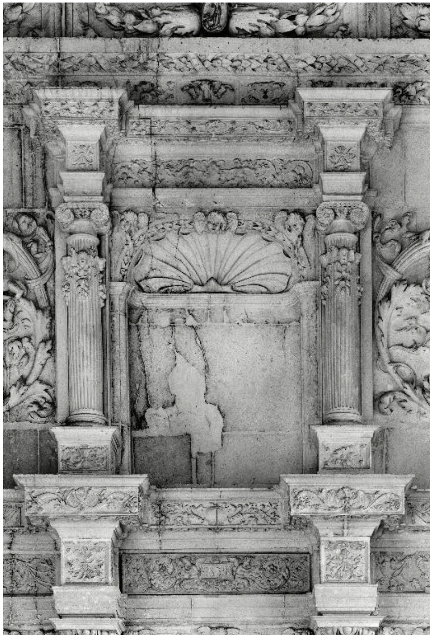
Vue de la niche du niveau supérieur.
