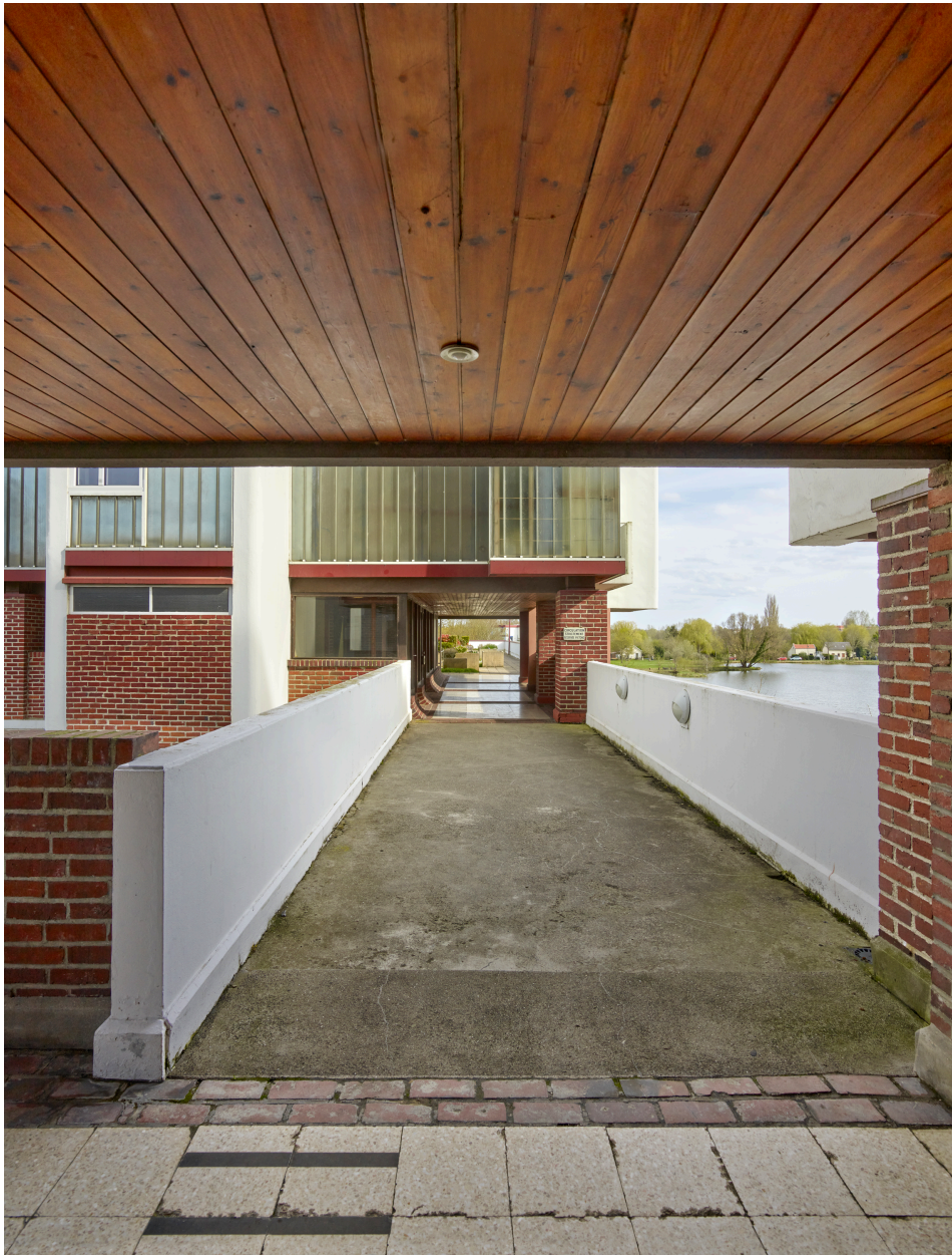
Passerelle entre les bâtiments G1 et G2.
