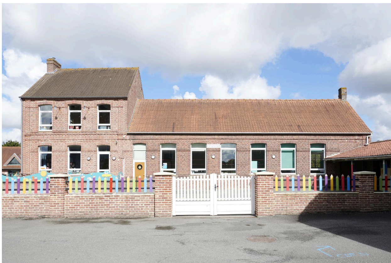
Façade sud, sur cour.
