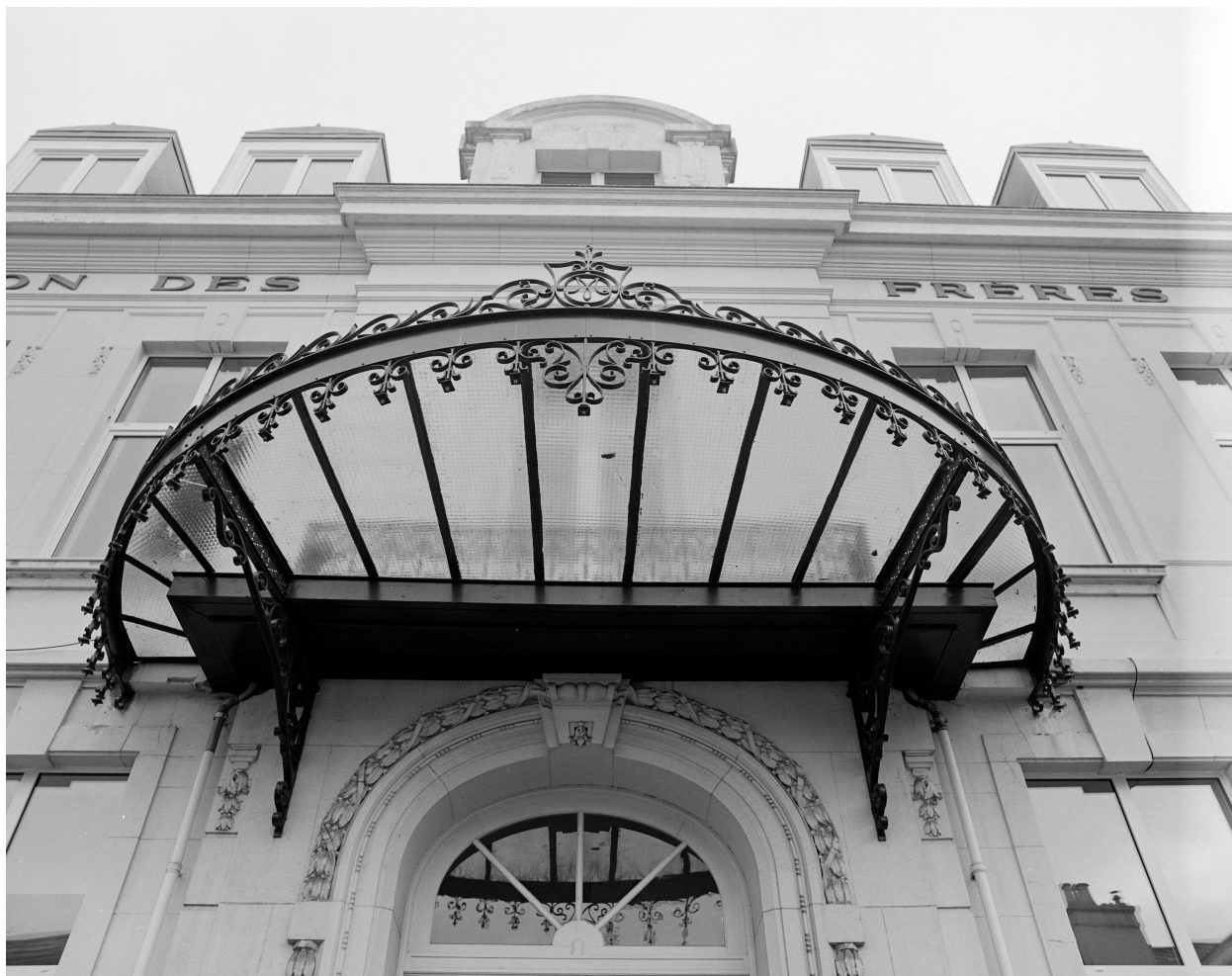
Marquise surmontant l'entrée du bâtiment principal.
