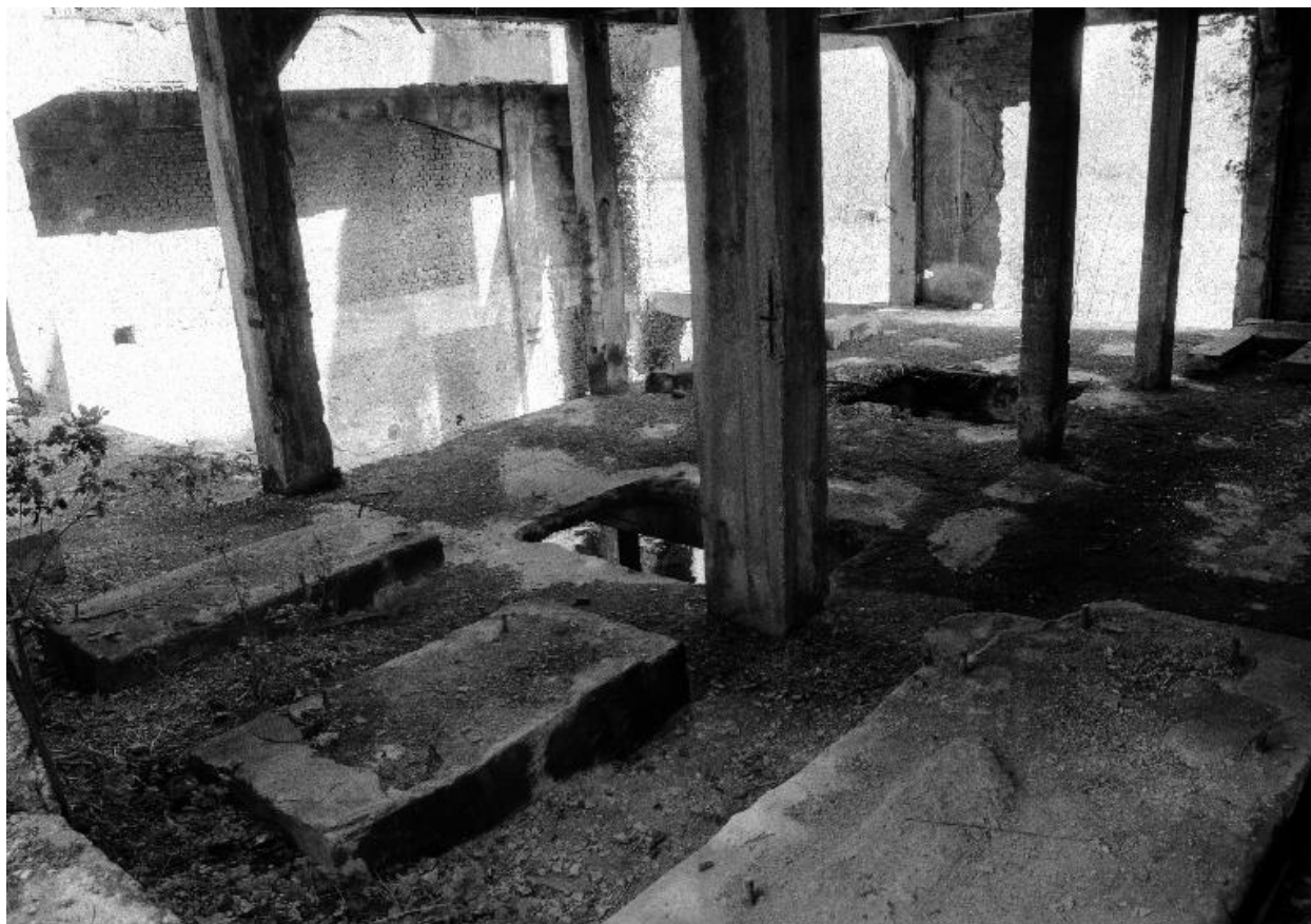
Atelier de fabrication, premier étage, salle des machines.
