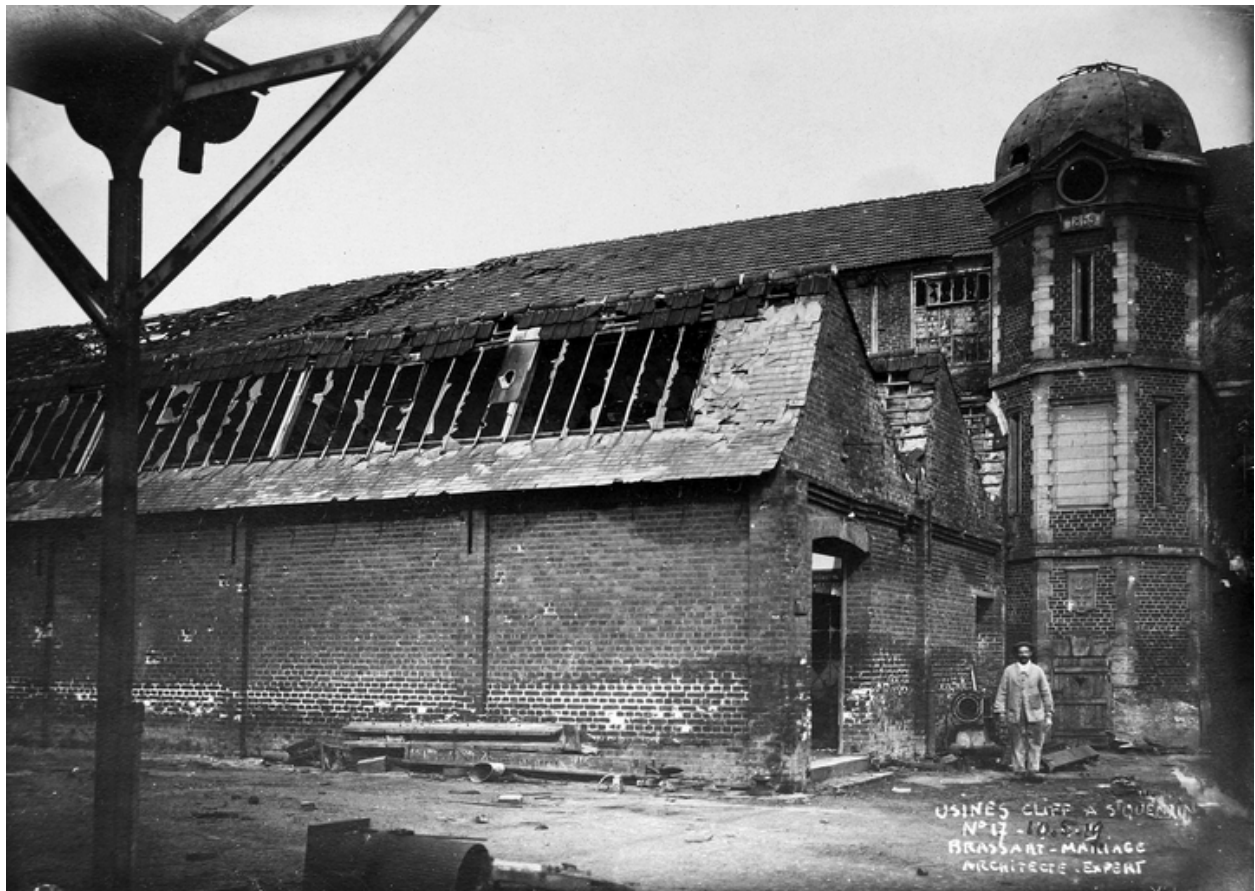
Façade est de l'atelier d'apprêt et de bordage, tour de l'horloge et atelier des métiers anglais (premier plan), par Brassart-Mariage, mai 1919 (AD Aisne).
