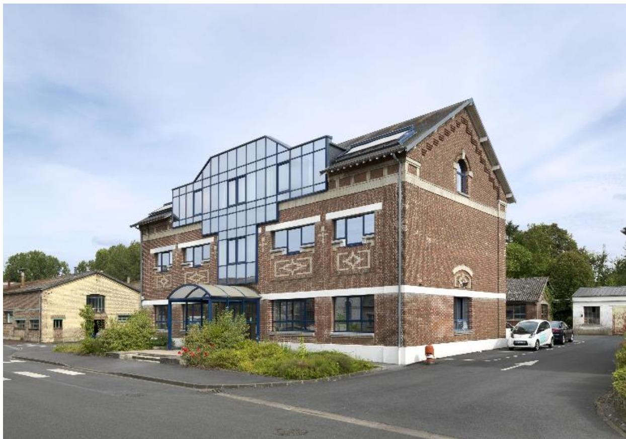
Bâtiment administratif, vue de trois-quarts.
