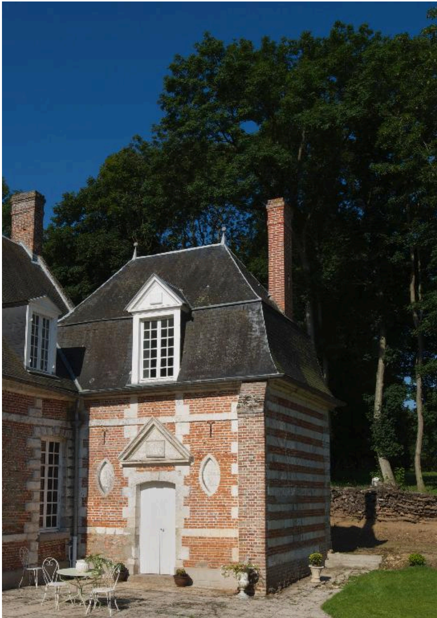
Pavillon en retour d'équerre sur cour à l'ouest du logis.
