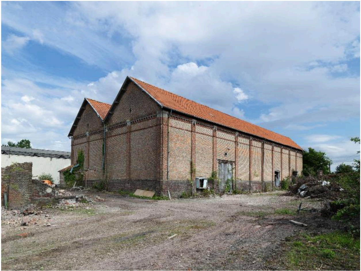
Vue d'ensemble des entrepôts avant destruction, juillet 2012.
