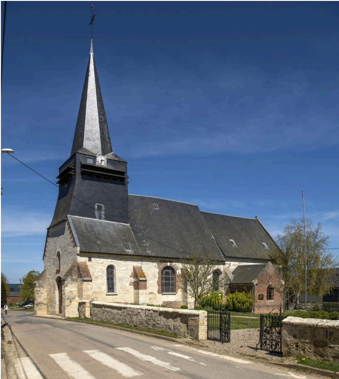
Vue depuis le sud.
