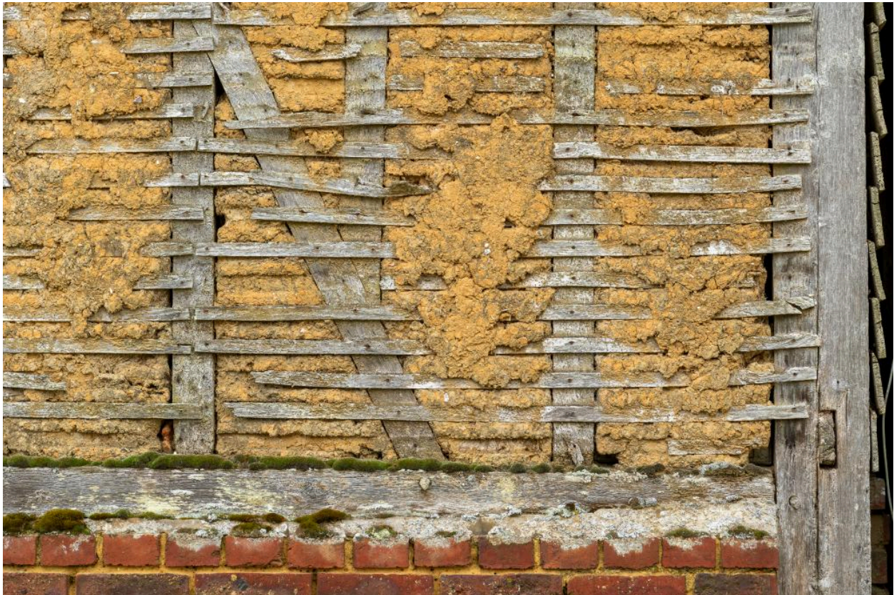
Détail de maçonnerie en pan de bois, clayonnage et torchis sur solin de brique, grange n°25 rue de la Sablonnière.
