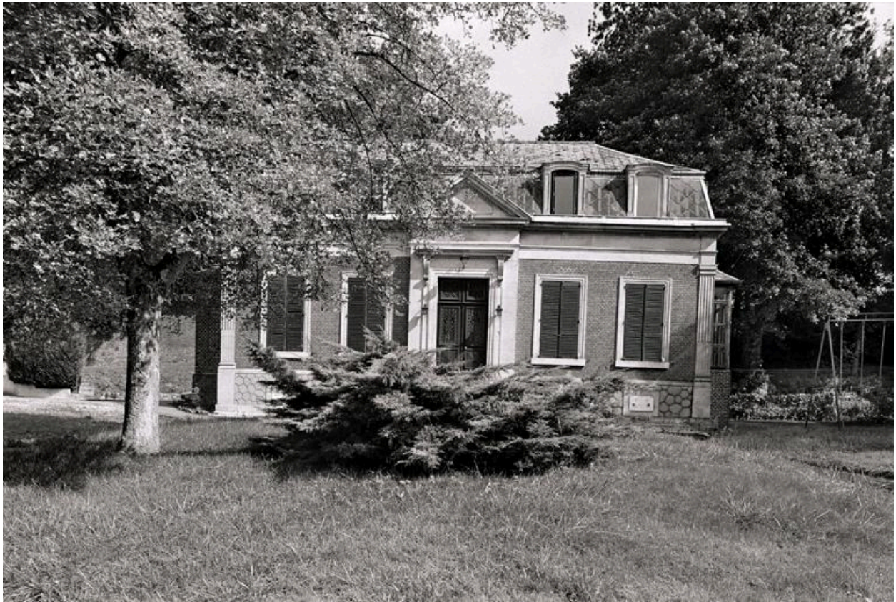
Vue de la façade principale, depuis la route.
