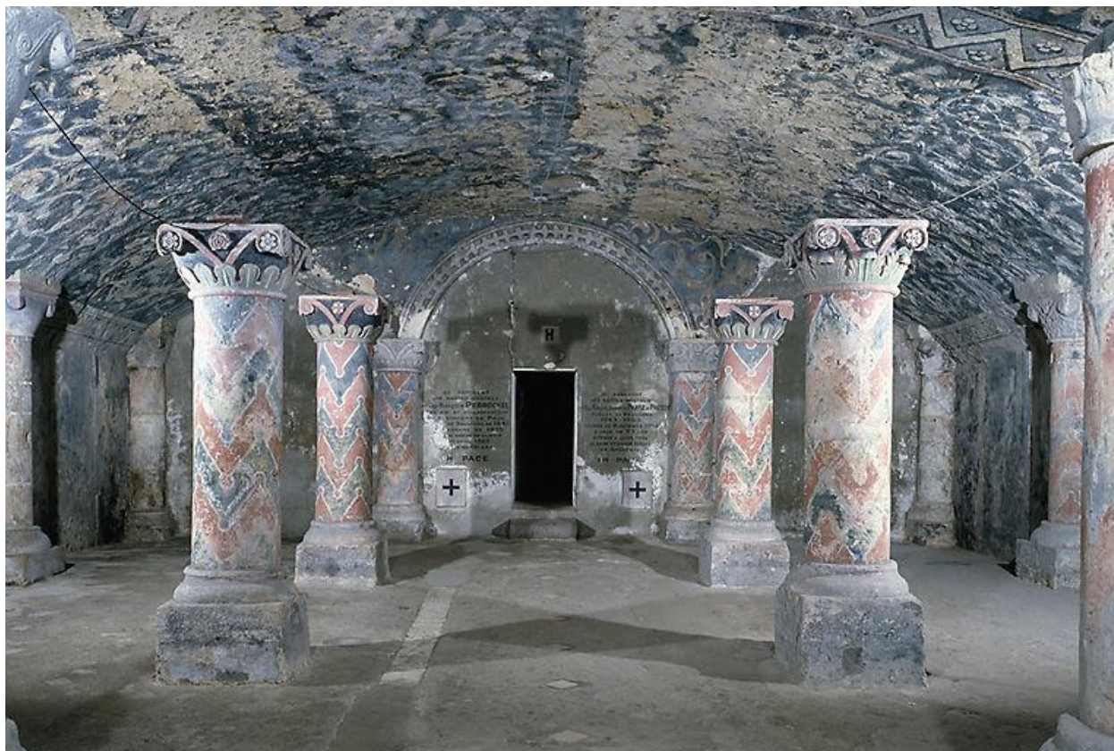
Vue de la crypte romane avant restauration.
