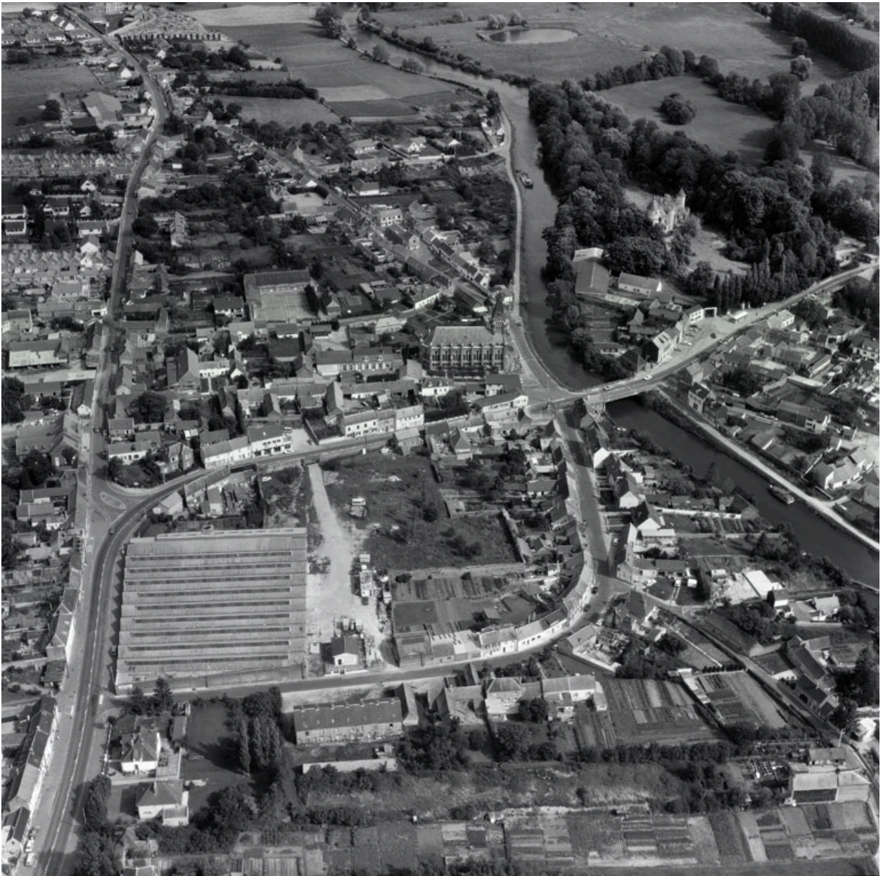
Vue aérienne, flanc ouest.
