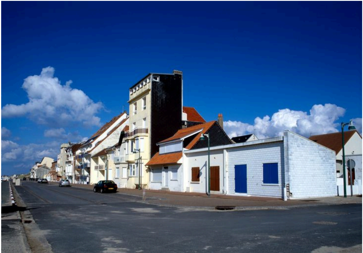
Les constructions du front de mer, vue depuis le sud.
