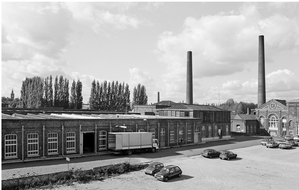
Vue générale prise vers le nord-ouest.
