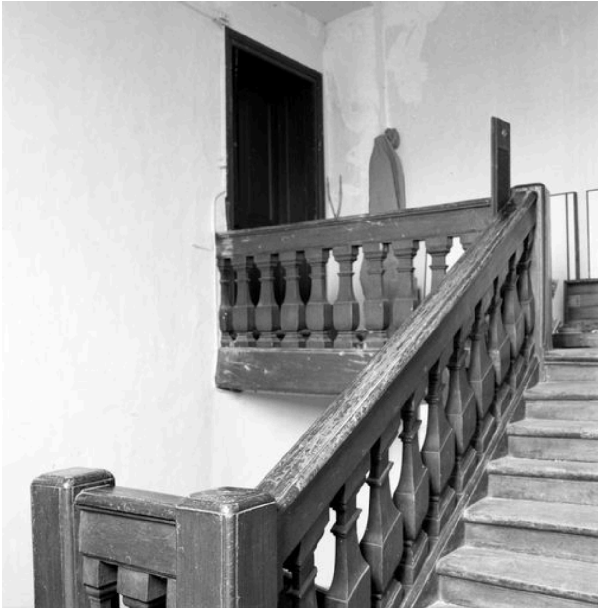
Aile de la rue de la Cavalerie : n° 35-37, escalier "de Louis XIV" desservant actuellement le 1er étage du corps de logis médiéval : 2e volée et palier.
