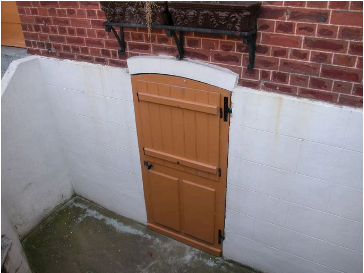
Porte d'accès au sous-sol, Villa Nenette, 46 avenue Carnot (1988 BB 219).
