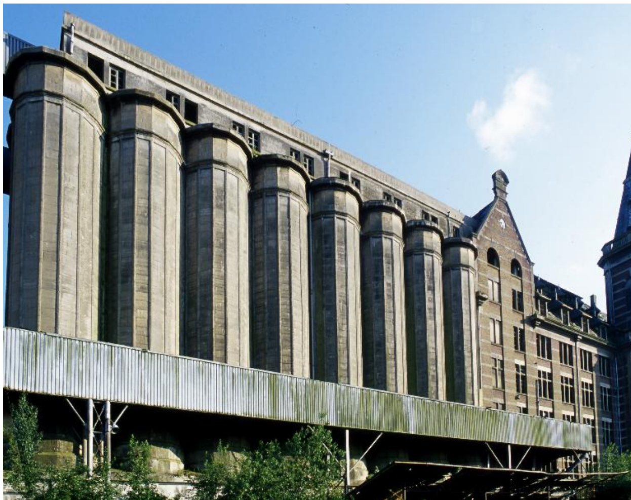
Les silos à grains vers le sud-est.
