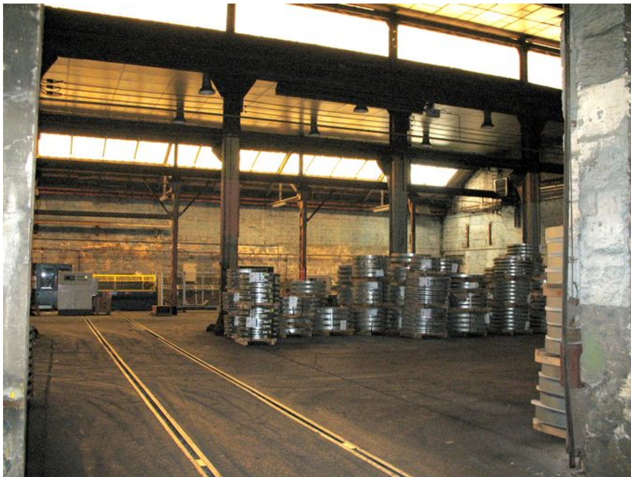
Intérieur de la fonderie avec les rails.
