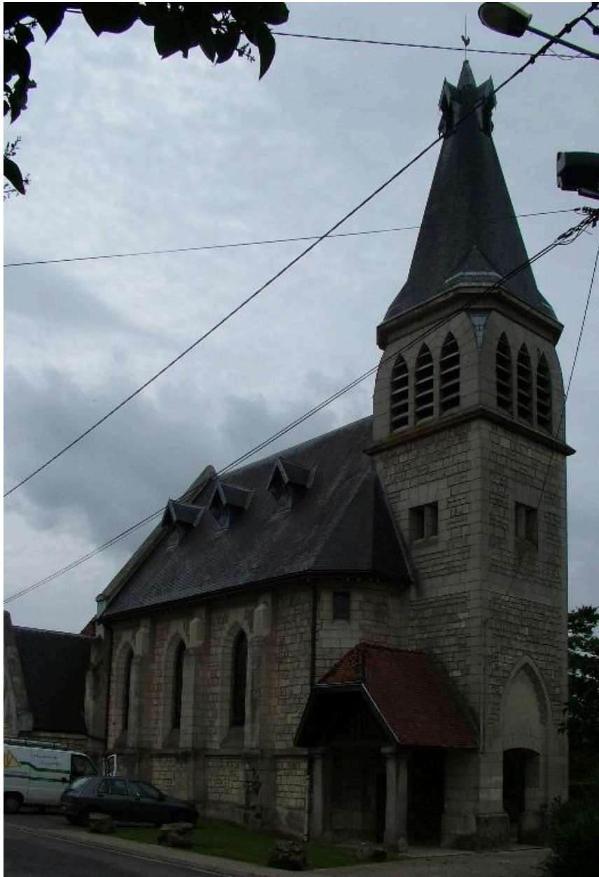
Vue générale, depuis le nord-ouest.
