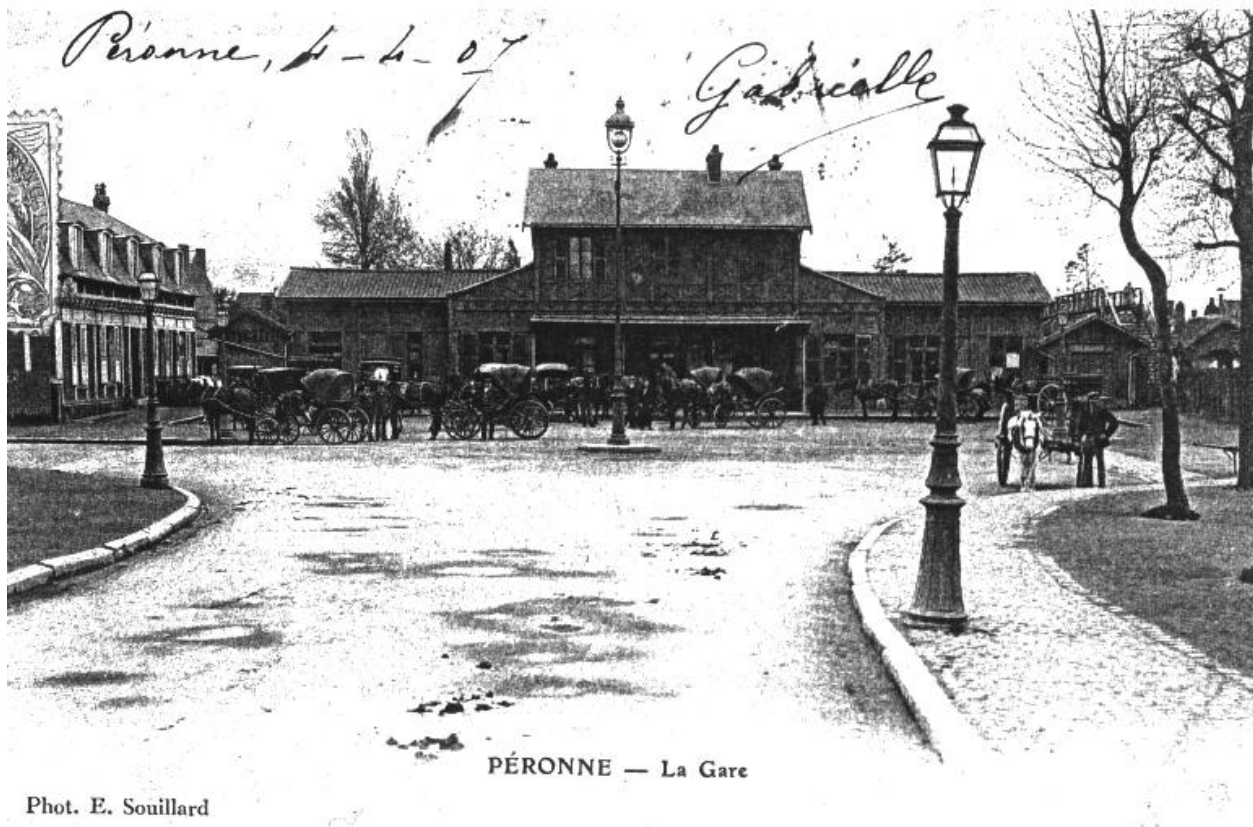
L'avenue de la Gare, avant 1909 (Musée Danicourt, Péronne).
