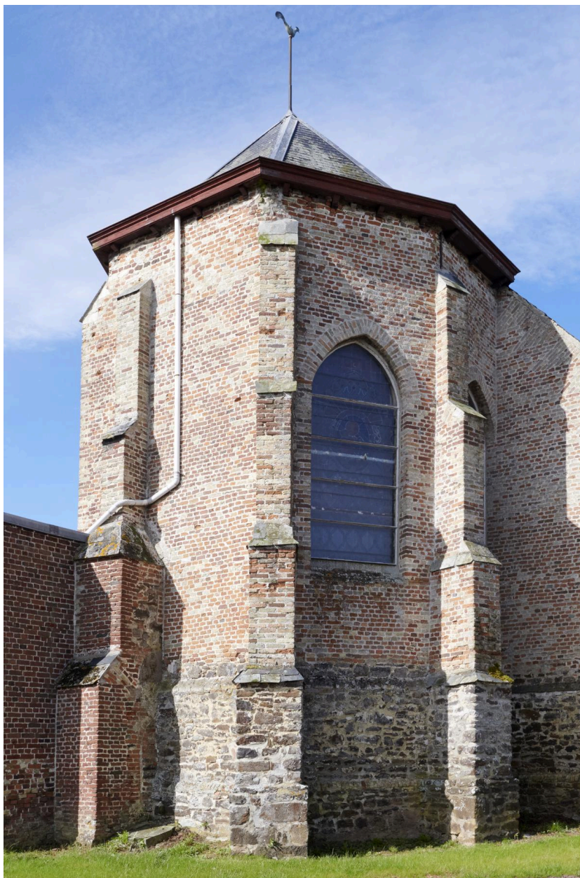
Vue extérieure du chœur.
