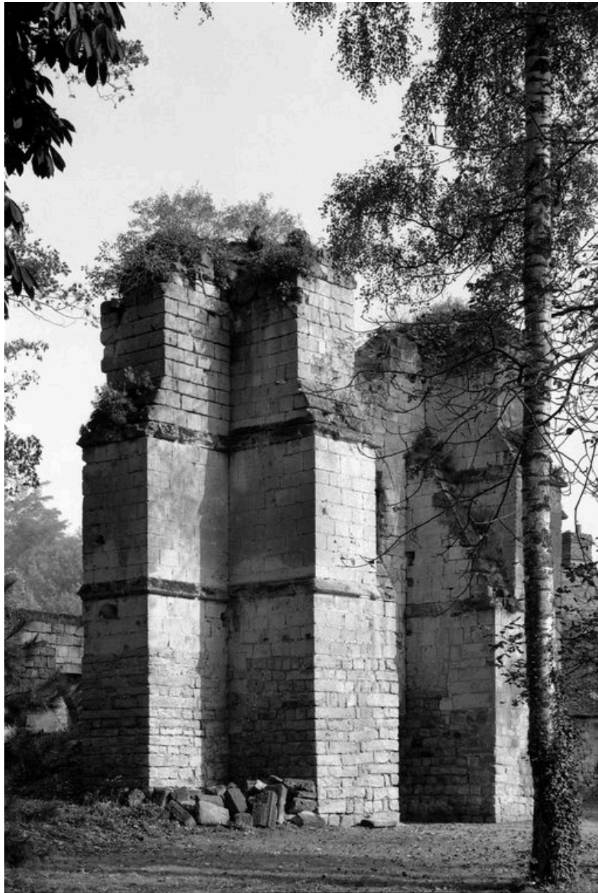
Ouvrage d'entrée. Détail des contreforts.
