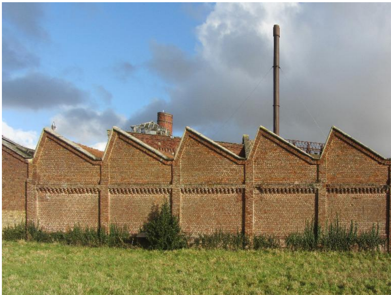
Pignons ouest en sheds des ateliers d'apprêts.
