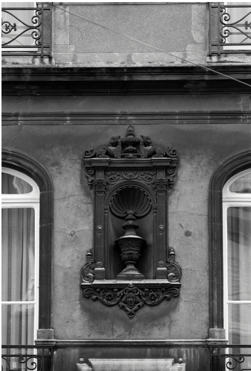
Façade sur voie, 1er étage, niche.
