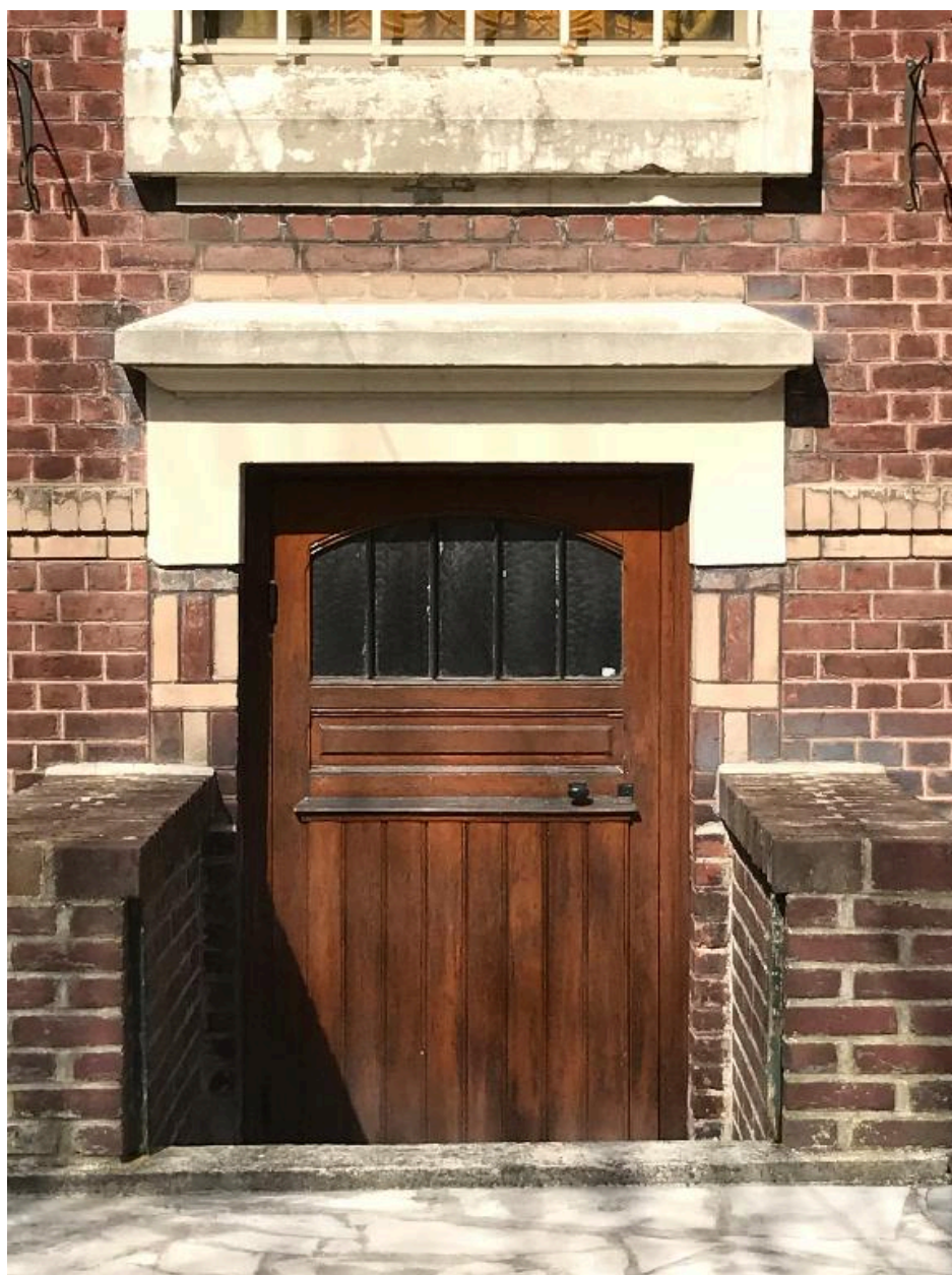
Détail de la porte de service en demi-sous-sol.
