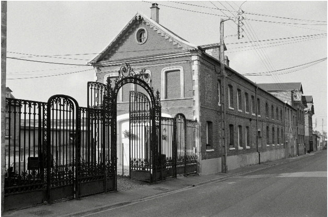
Vue de la grille du logement patronal et des locaux de la première usine, depuis la rue Henri-Barbusse, en 1990.
