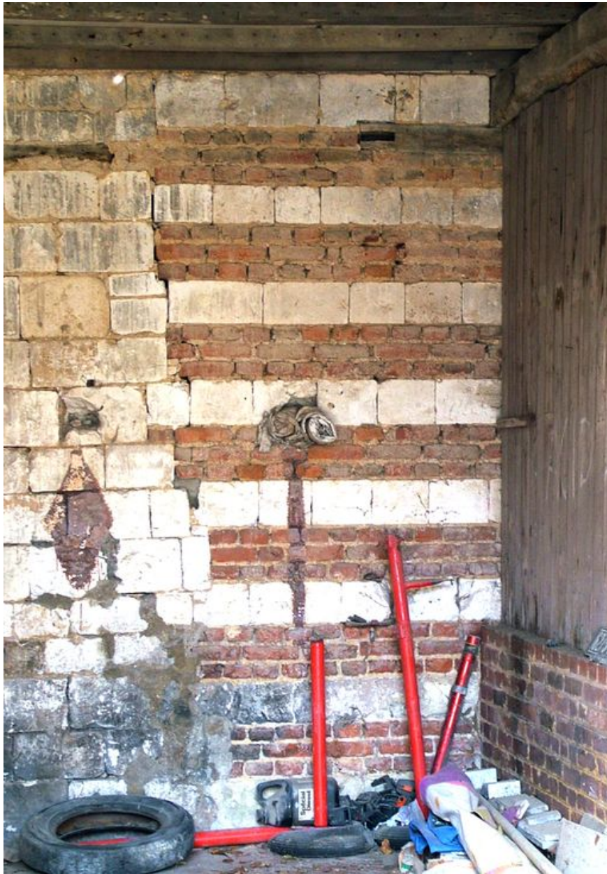
Détail de l'appareil mixte du mur arrière des communs.
